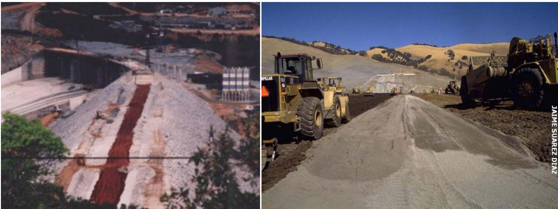
Figura 3. 11 Espesor del núcleo en el apoyo de la cortina en las laderas de la boquilla
