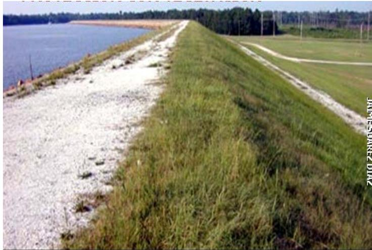
Figura 3. 38 Protección de taludes utilizando pasto en el paramento seco
