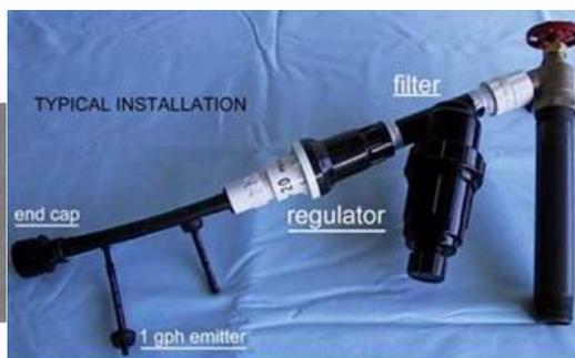
Figura 4. 51 Instalación típica de un sistema por goteo
