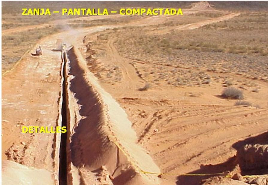
Figura 3. 25 Material de desplante de una pantalla impermeabilizante
