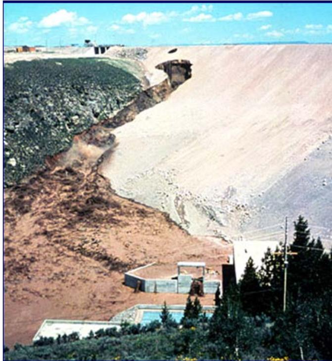
*Figura 3. 8 Falla de una presa por filtración en un estribo*
