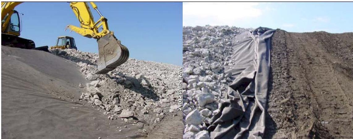
Figura 3. 16 Protección de taludes utilizando enrocamiento.
